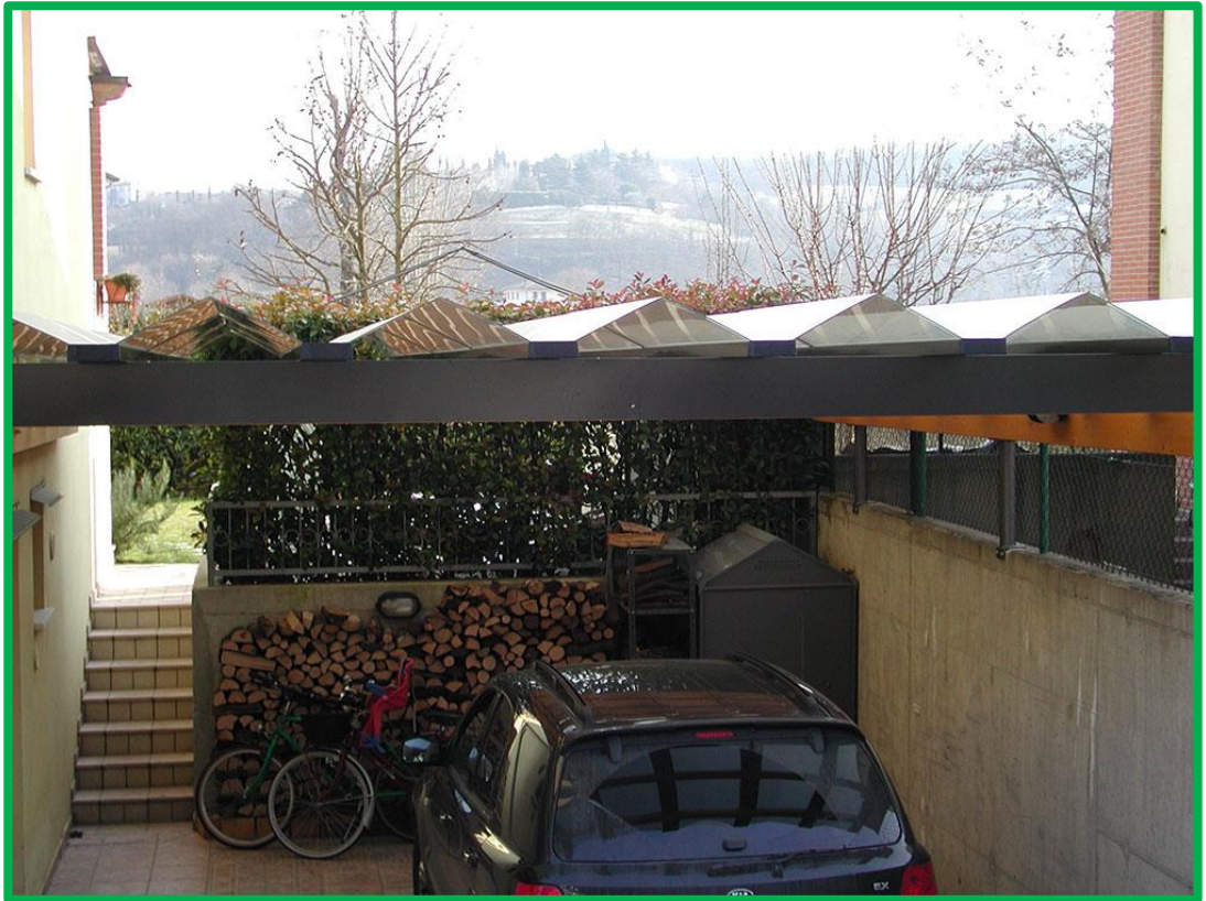
Pergola con copertura in plessiglass “piramidale”
