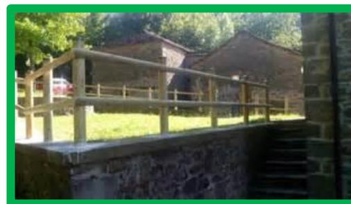
Staccionata interamente realizzata in legno di pino massiccio impregnato in autoclave e certificato come protezione per uso esterno.
