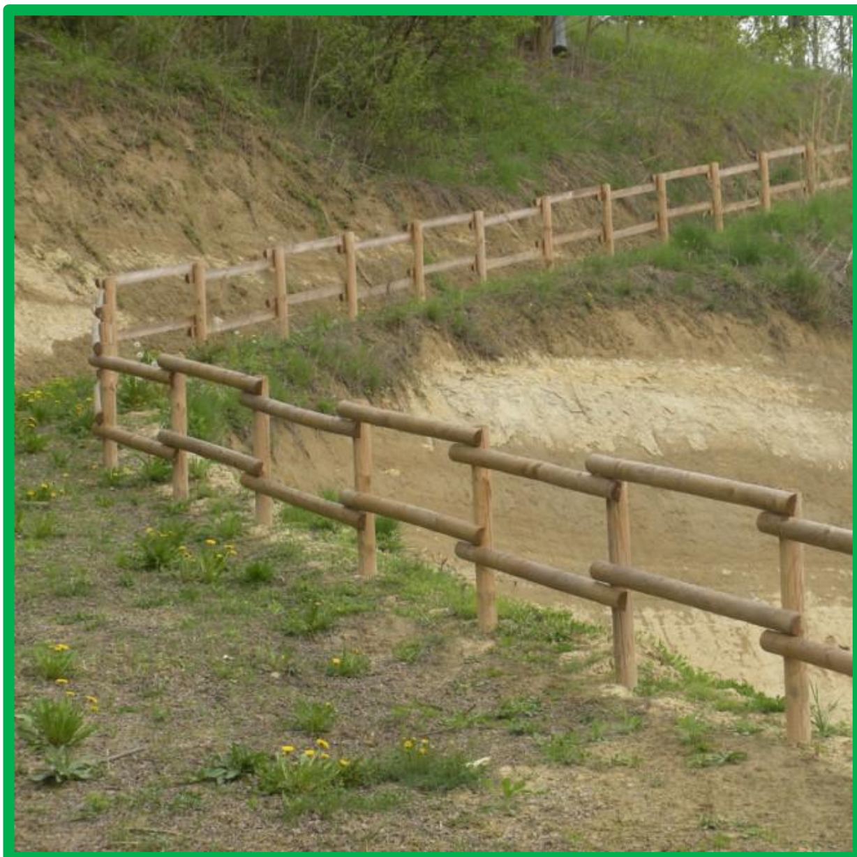
Staccionata valdostana a mezzi pali
