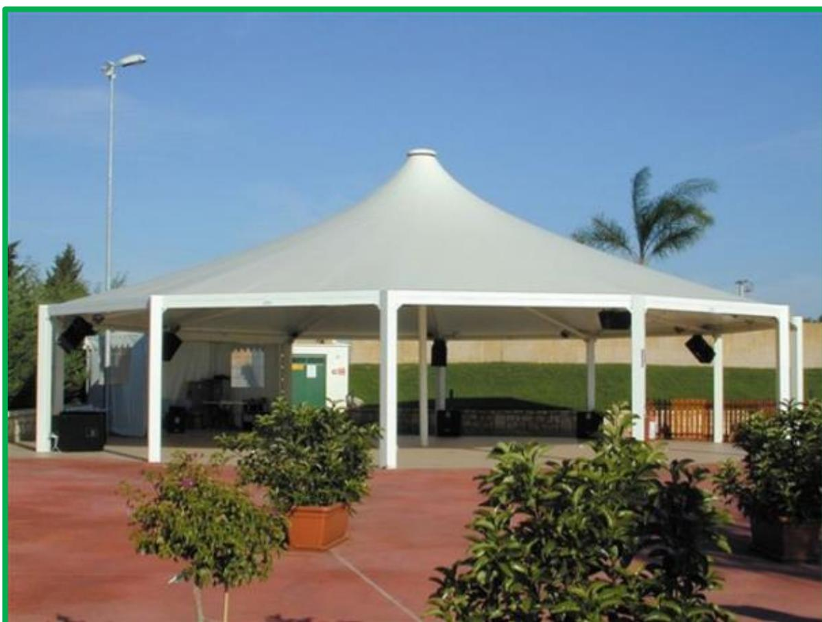
Attualmente l'utilizzo di materiali resistenti come l'alluminio e il PVC rende il gazebo più simile ad una tensostruttura in grado di coprire aree piuttosto estese garantendo alte resistenze al carico neve e all'azione del vento.
